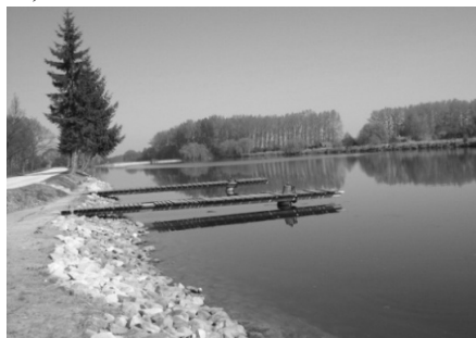
Rys. 7. Lewostronna grobla boczna zbiornika: a – układanie narzutu kamiennego na skarpie odwodnej, b – budowla po odbiorze technicznym
