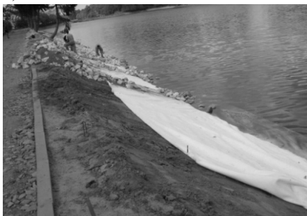
Rys. 7. Lewostronna grobla boczna zbiornika: a – układanie narzutu kamiennego na skarpie odwodnej, b – budowla po odbiorze technicznym
